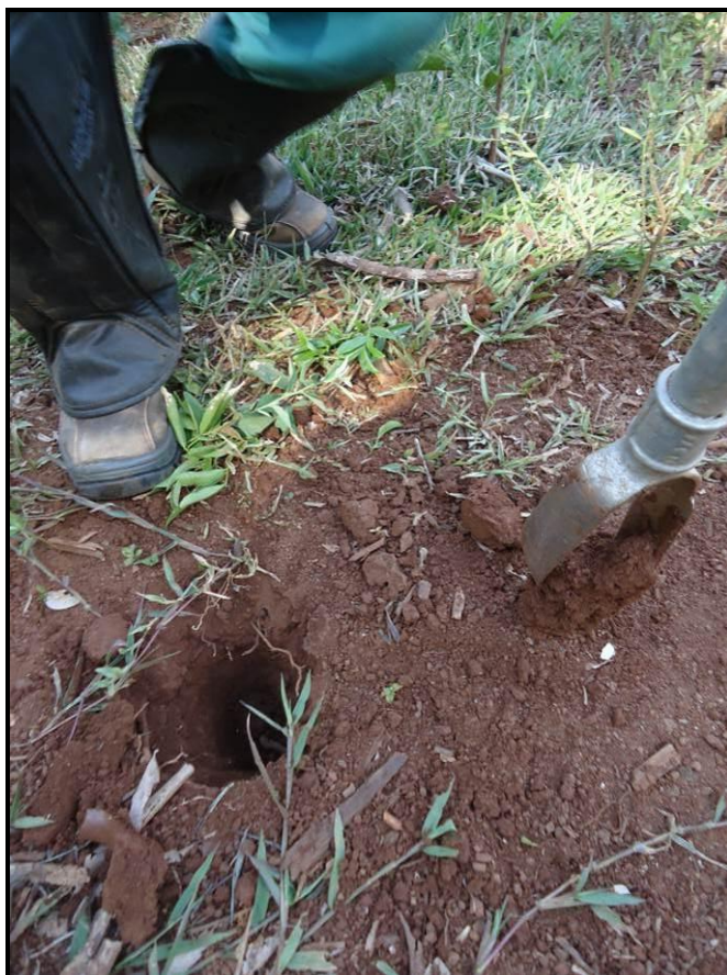
Figura 55 – Execução da sondagem ST-04.
