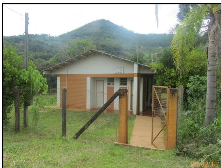
Figura 301 – Posto de Saúde localizado na Comunidade Ponte do Iratim.
