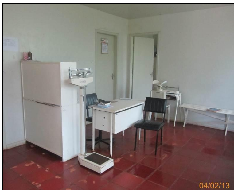
Figura 247 – Instalações do posto de saúde localizado na Comunidade Ponte do Iratim .
