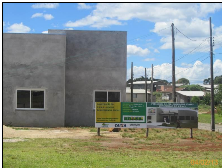
Figura 226 – Nova sede do CRAS em estágio final de construção, contígua à atual edificação que abriga a entidade.
