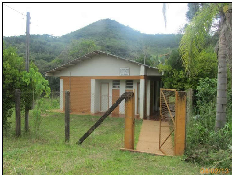
Figura 246 – Posto de saúde na Comunidade Ponte do Iratim.
