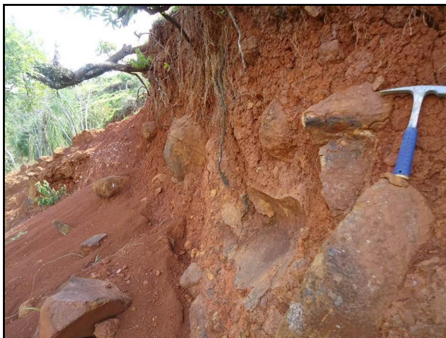
Figura 68 – Afloramento rochoso com rocha sã e porções alteradas e saprólito.
